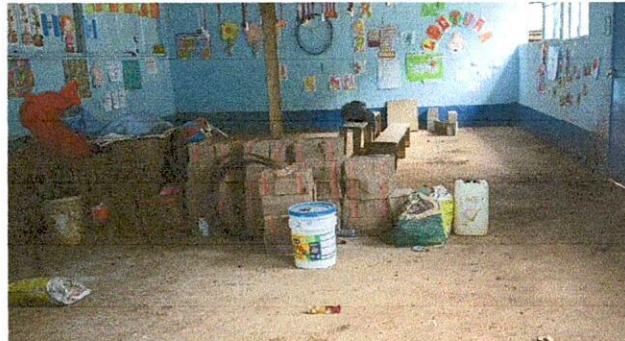
Foto: 2 MEJORAMIENTO DE PISO MÓDULO 1
