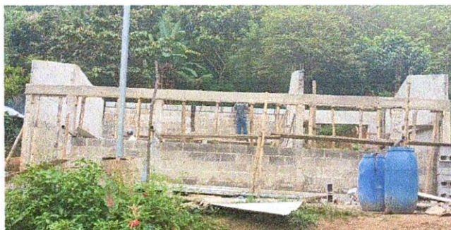
Foto: 3 MEJORAMIENTO DE PARED MÓDULO 2
