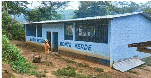
Foto: 1 INSTALACIÓN DE BARANDALES MÓDULO 1
